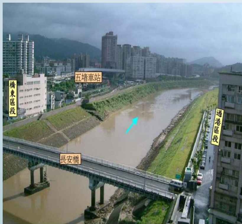
橋東區段及過港區段堤防完工後
